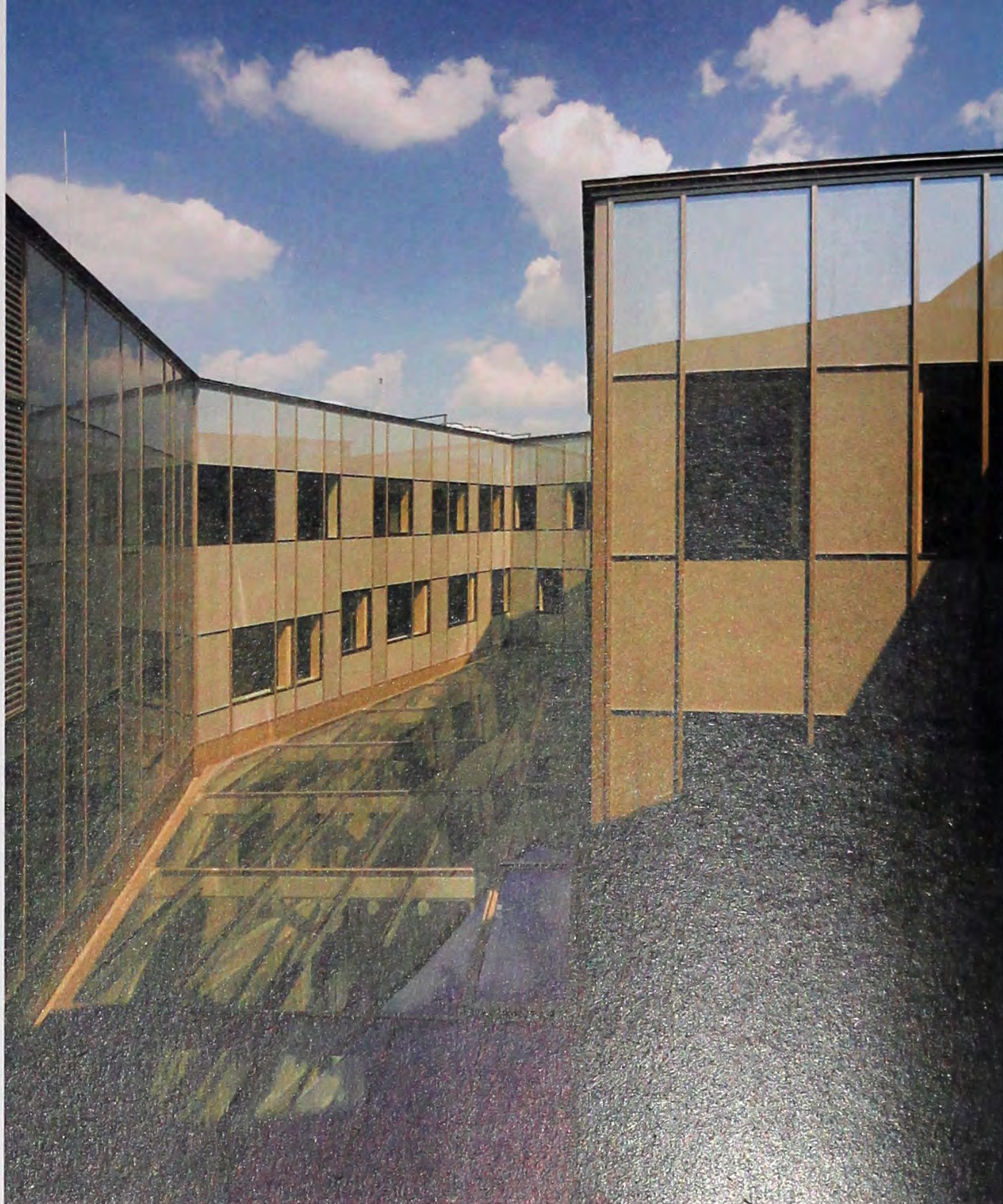
Az új ráépítés építészeti karakterének visszafogottsága segíti az illeszkedést
